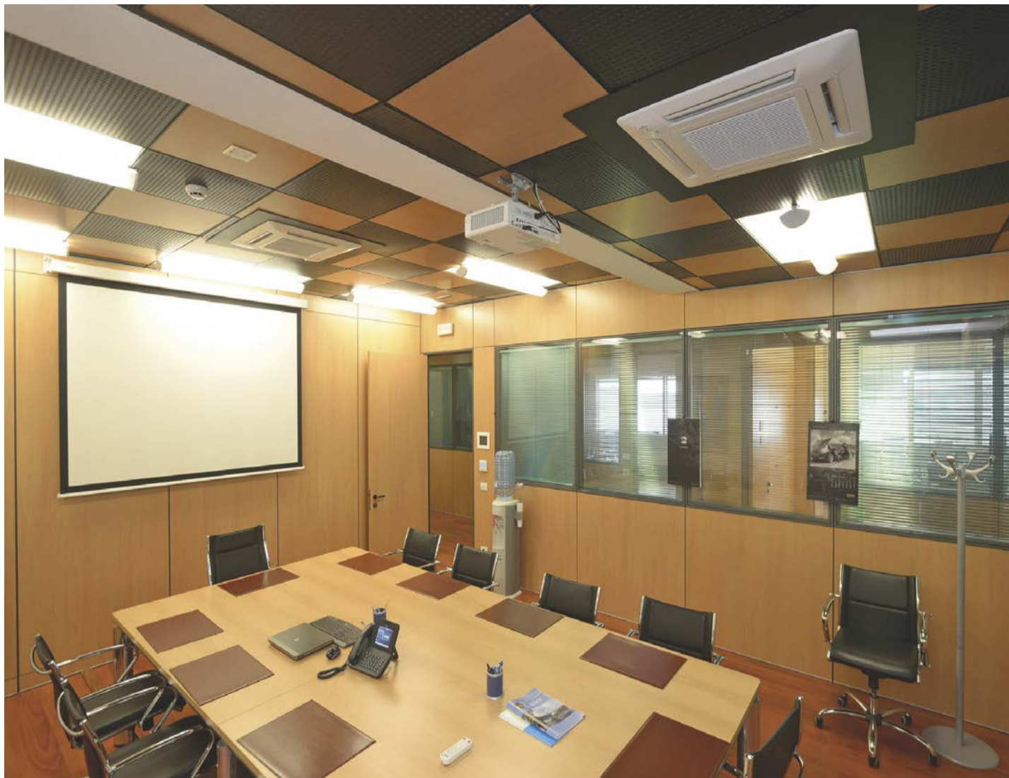
LE UNITÀ A CASSETTA installate nella sala riunione degli uffici direzionali.
